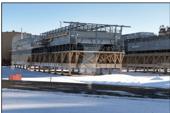
图2 北极某油气处理站场架空基础
